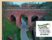
AG Brückenfreunde Pflegearbeiten an einem von 4 Viadukten
