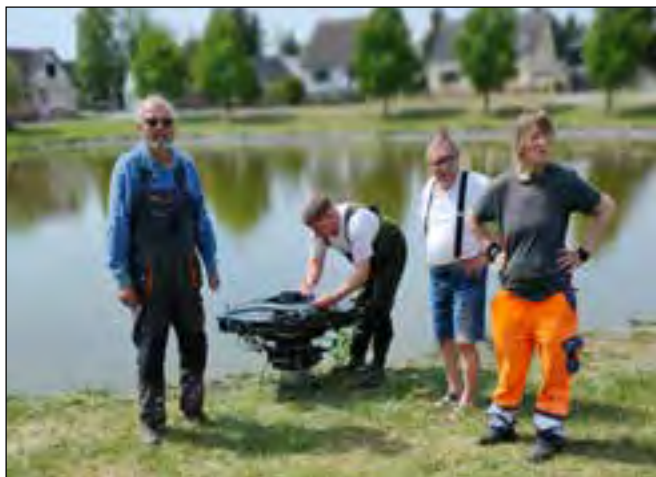
Podelziger beim Aufbau der Pumpe
