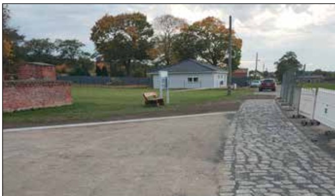
Neu gestaltete Einmündung in die Straße Unterdorf (Foto: H.B.)
